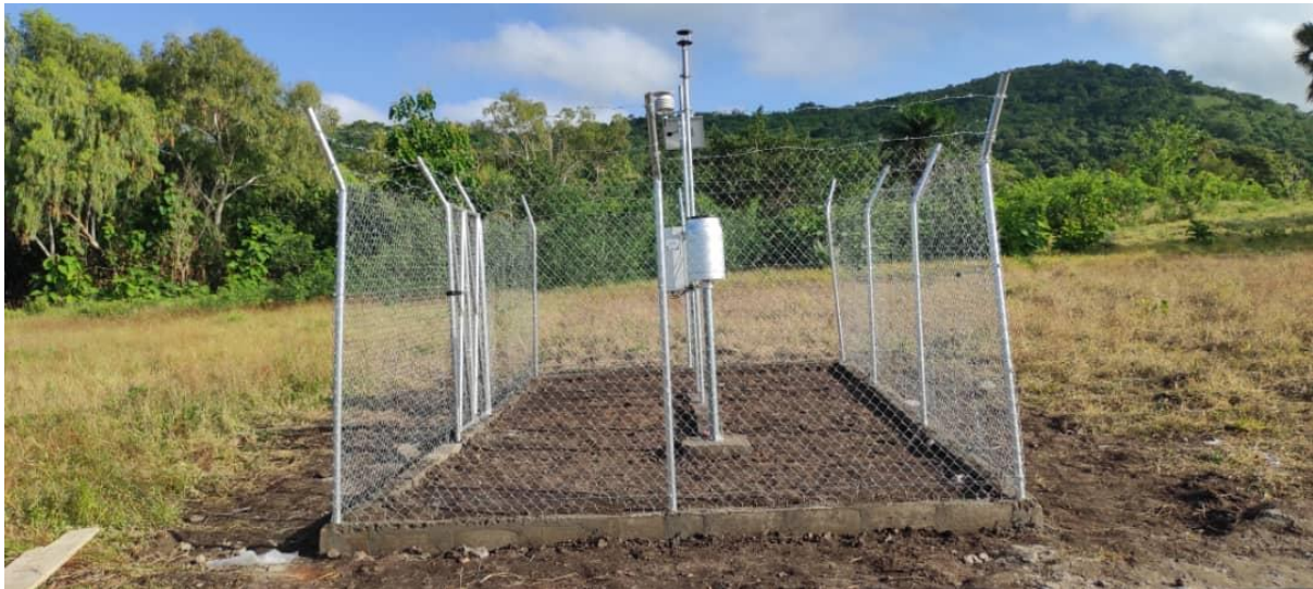
Figure 3: Station hydrométéorologique de Daoudè à la fin des travaux.
