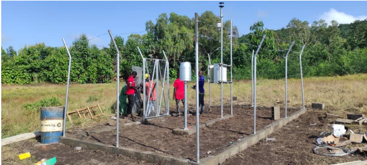
Figure 2: Station hydrométéorologique de Daoudè lors des travaux d'installation
